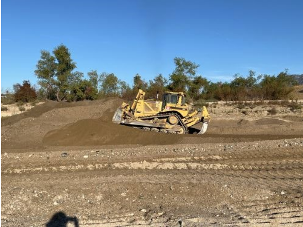
Bulldozer_compiling_sediment_facingW.jpg -118.17187488055556 34.19254263888889
