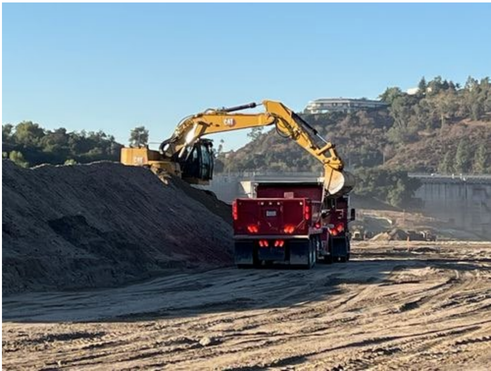
Excavator_filling_dump_trucks_facingSE.jpg -118.17287414722223 34.19197494444444
